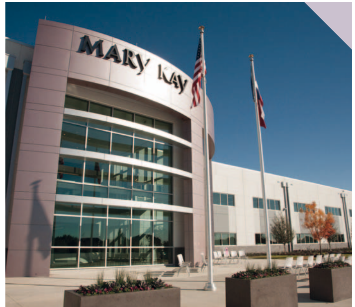
Construido sobre una parcela de 10 hectáreas, el Centro de Fabricación e Investigación y Desarrollo Richard R. Rogers (R3), con certificación LEED Silver, está ubicado en Lewisville, Texas (Estados Unidos).
